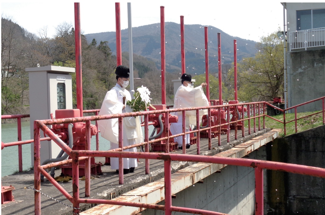
令和5年度水入祭挙行 (場所 温湯頭首工)
